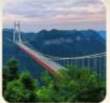
สะพานอ้ายจ้าย
